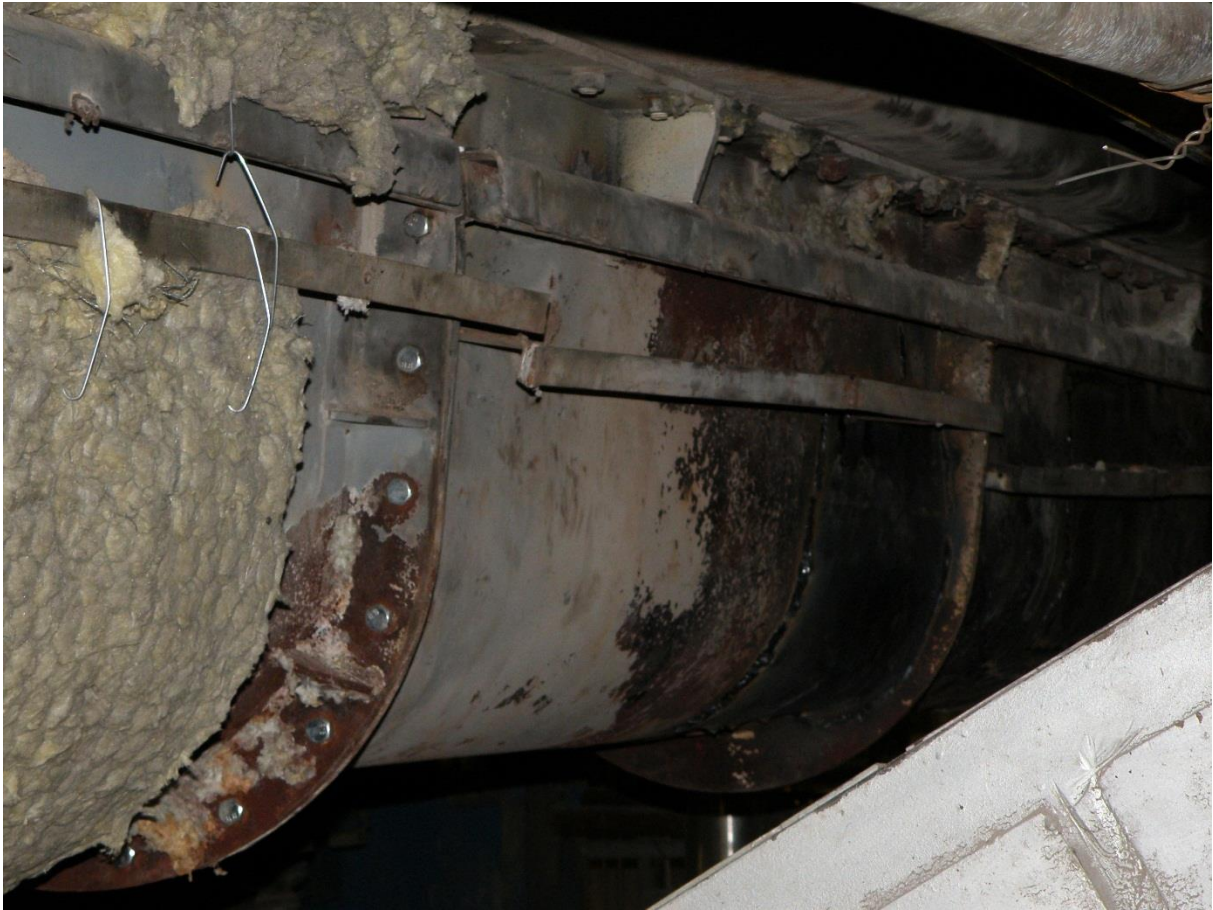
6. kép: a vályú két részének illesztése kívülről
